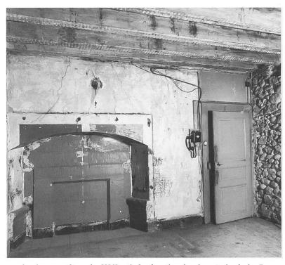
Fig. 43. «Chaudanne» placée au milieu du XVI siècle derrière la cheminée de la figure précédente. Cette niche permettait de chauffer la pièce par la diffusion de la chaleur de la cheminée de la cuisine.
