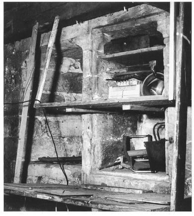
Fig. 62. Porte cintrée, armoire et fenêtre dans la façade côté lac de la cave du XIII<sup>e</sup>-XIV<sup>e</sup> siècle, du nº 15 de la ruelle des Galeries.
