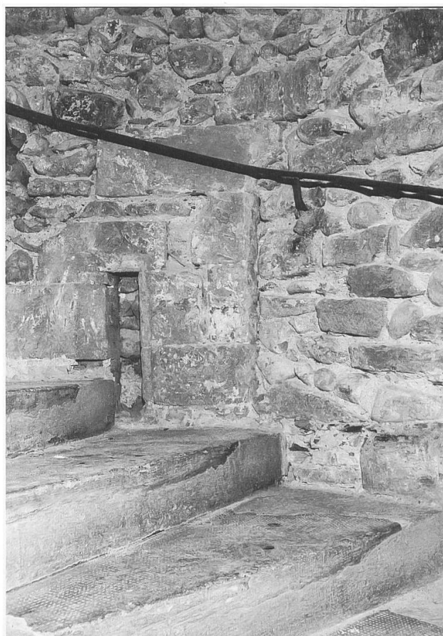
Fig. 41. Petite baie chanfreinée et piédroit de la porte de la façade primitive du n° 35 de la rue du Midi, en partie masqués par les marches de l'escalier à vis du XVI e siècle.
