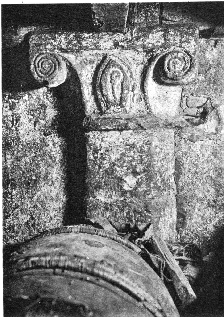
Cave du xiv e siècle — Détail d'un des chapiteaux
