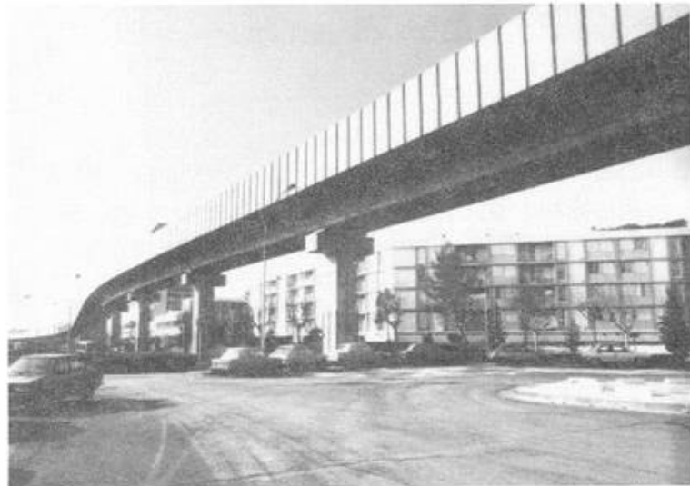
Fig. 2 : Le viaduc de la Rose
