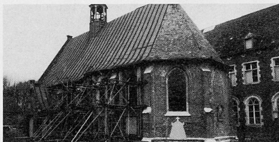
Fig. 1 Ancien hôpital et chapelle en annexe à Herentals (Belgique)
