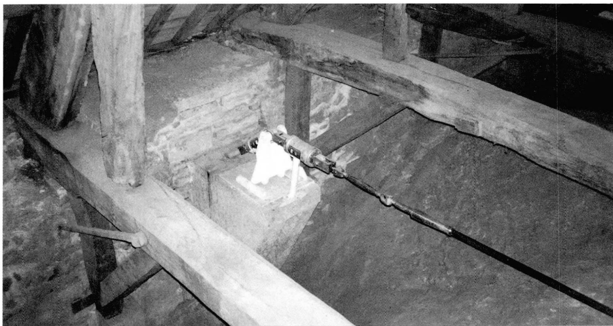
ACCROCHAGE DE TRAPEZE EN COMBLE
