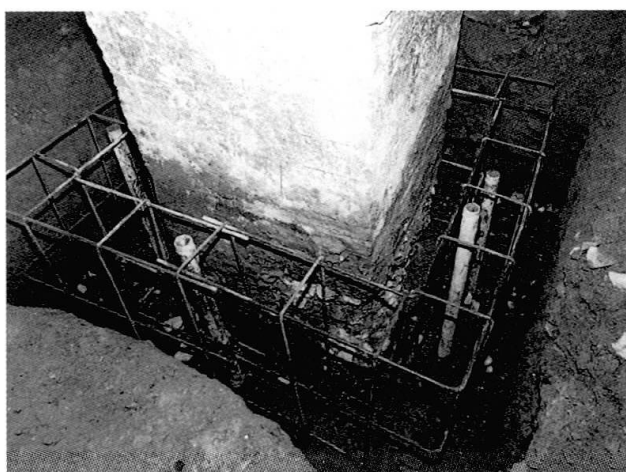
Fig. 6 - Collegamento tra basamento del pilastro e testa dei micropali.
