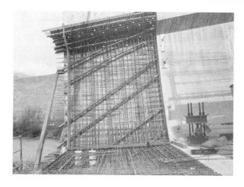
Vue d'ensemble Construction d'un fléau Etape d'encorbellement
