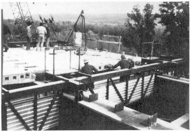
Fig.3- Assemblage des éléments préfabriqués.
