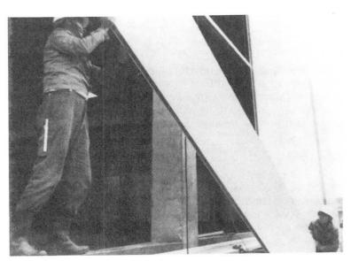
Abb.2: Montage von Sandwich-Wandbauteilen
