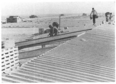
Abb.l: Montage von Sandwich-Dachbauteilen
