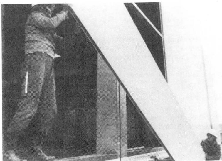
Abb.2: Montage von Sandwich-Wandbauteilen
