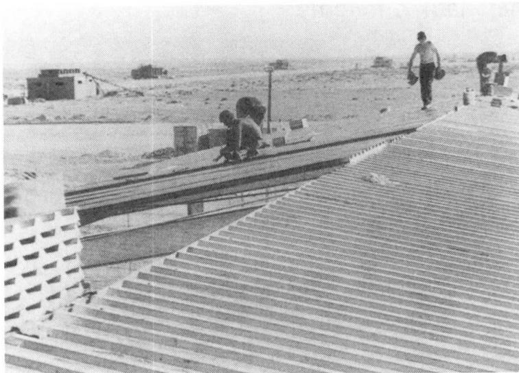
Abb.1: Montage von Sandwich-Dachbauteilen
