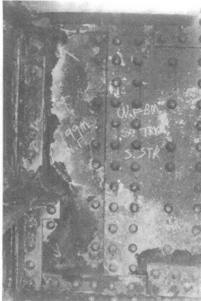
Fig. 3 Web Deterioration
