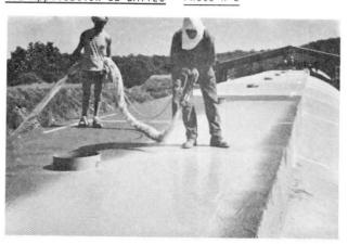
Lorsque les préparations ont été réalisées sur une zone assez grande, l'application du primaire Solyprim B et du BAYTEC ont pu commencer. Le délai d'intervention entre les 2 produits a été en moyenne de 16 h (application du primaire la veille), le BAYTEC nécessite une application sur 2 couches (2 passages espacés d'environ 20 à 30 s) d'épaisseur unitaire 2 mm.
