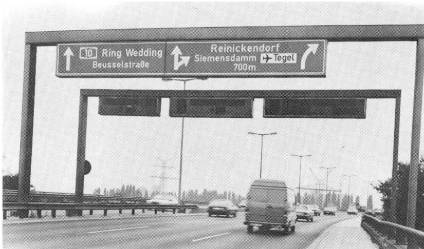
Fig. 1 Schilderbrücken der Berliner Stadtautobahn; vorn Neukonstruktion aus Stahl
