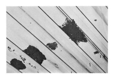
Abb. 1 Von den Hohlräumen har korrodierte Stahltrapezbleche des Daches einer Destillatlagerhalle. Essigsäare bildet die Ursache dieses Schadens.
