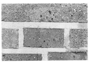
Fassade C, dargestellt in Bild 4, ebenfalls vor etwa 15 Jahren hydrophobiert. Bild 5 und 6 zeigen ausgewählte Bereiche der Fassaden B und C in Nahaufnahme. Neben Abplatzungen mit 5 bis 10 mm Scherbendicke sind deutliche Abblätterungen des Steinmaterials und starke Fugenschäden zu erkennen.
