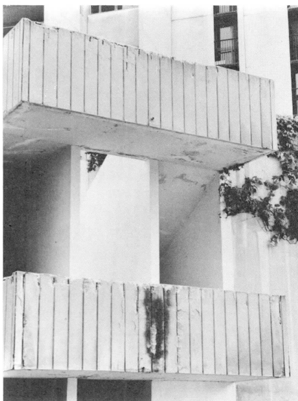
Fig.2 Béton mal traité
