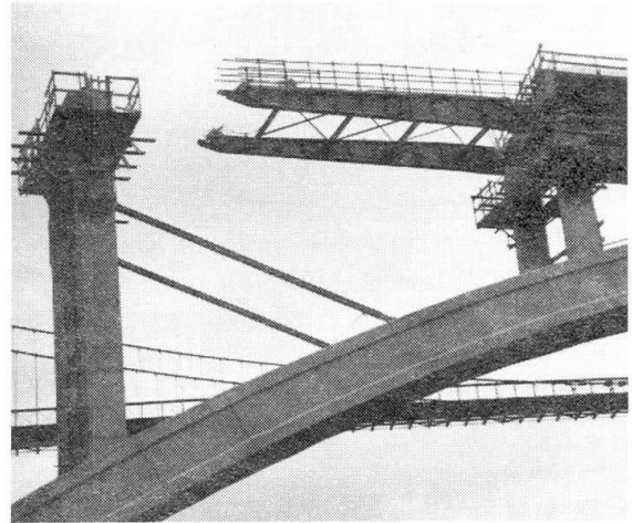
Poussage du tablier sur l'arc
