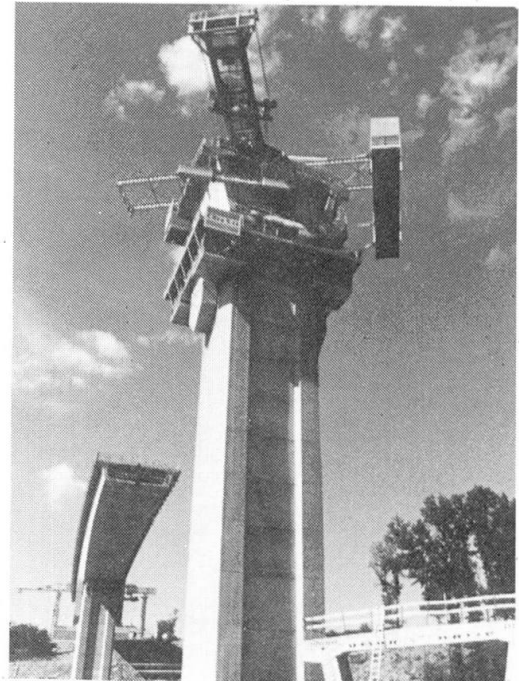
Photo 5 : Pose des voussoirs
