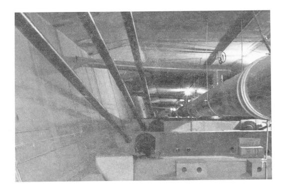
Figure 2 : Câbles extérieurs au béton à l'intérieur du caisson Externals tendons inside one cell
