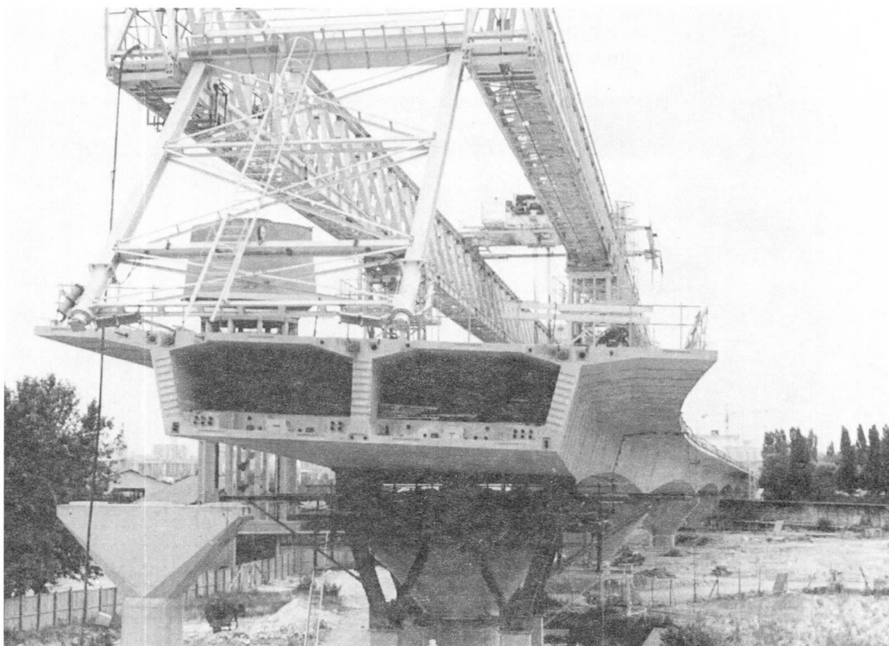
Figure 1 : Vue générale du montage des voussoirs Segmental view of the segment erection
