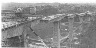
Photo 3: Vue d'ensemble des fléaux avant basculement
