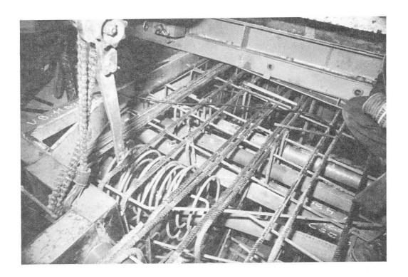
Figure 3 : Vue d'un déviateur avant bétonnage View of a deviating block before pouring of concrete
