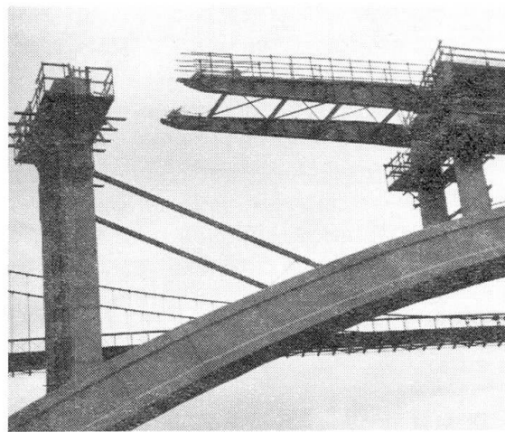
Poussage du tablier sur l'arc
