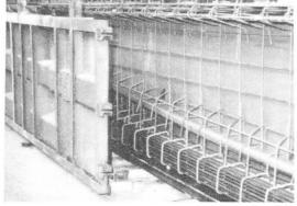
Fig.2 Poutre prête au bétonnage
