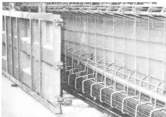
Fig.2 Poutre prête au bétonnage
