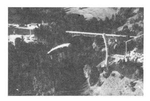
Fig. 4 Construction d'un arc par rotation dans un plan vertical Pont d'Argentobel
