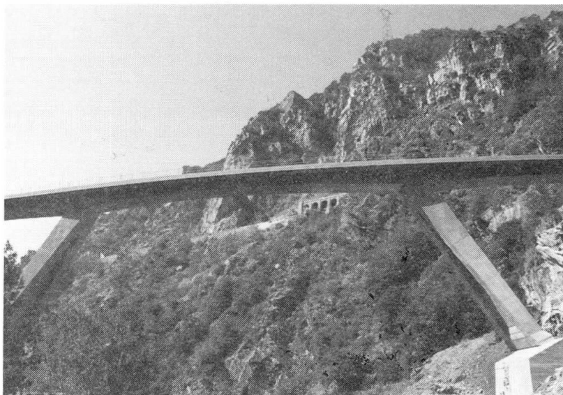
Photo 1 – Ligne de Coni à Vintimille Viaduc de Scarassoni – Caisson en béton précontraint, Long. 117 m
