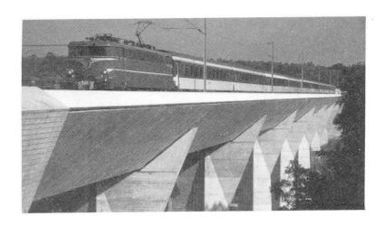
Photo 2 – Ligne de Paris à Lille, Viaduc de Commelles – Caisson en béton précontraint pour 4 voies, Long. 400 m
