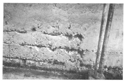
Photographie 2 Exemple de détérioration progressive du béton par défaut d'enrobage des armatures.
