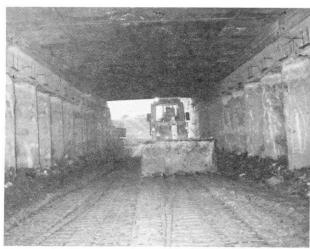
Fig. 7 Los Stammstrecke - Herstellen der Fig. 8 Aushub unter dem fertigen Deckel. Tunneldecke auf dem vorbereiteten Erdplanum und biegesteife Verbindung mit Tunnel kreuzen den Großbohrpfählen
