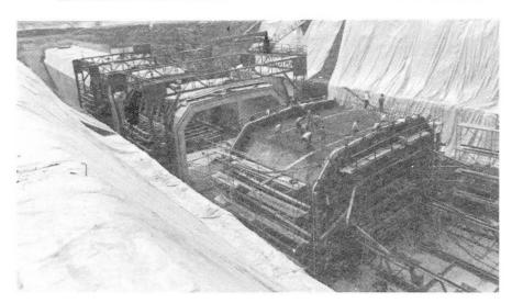
Fig. 2 Monolithische Herstellung der Tunnelblöcke in frei geböschter Baugrube beim Los Langes Feld
