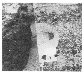
Fig. 2 Détail d'une armature Recouvrement 4 cm – acier sain
