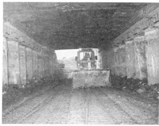
Fig. 7 Los Stammstrecke - Herstellen der Fig. 8 Aushub unter dem fertigen Deckel. Tunneldecke auf dem vorbereiteten Erdplanum und biegesteife Verbindung mit Tunnel kreuzen den Großbohrpfählen
