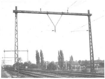
Fig. 3 Portique en béton précontraint
