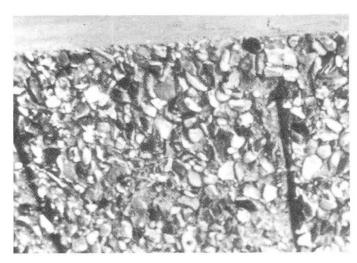
Photographie 3 Détail d'un flan de poteau dont le côté vu a été traité avec un retardateur de surface.
