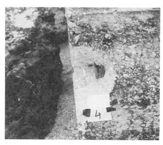
Fig. 2 Détail d'une armature Recouvrement 4 cm – acier sain
