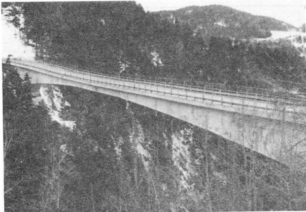
Fig. 2 - Vue du pont
