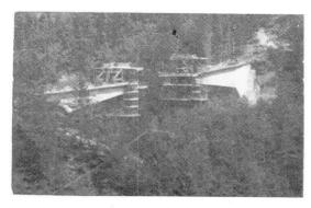
on ne pouvait pas trouver sur place ou pas trop loin des granulats normaux de bonne qualité indiqués pour béton précontraint. Compte tenu de ces faits, la différence entre le coût des granulats pour béton léger et celui des granulats normaux était assez petite. En effet, lors du budget, compte tenu de tout ce qui précède, et aussi d'autres circonstances favorables, on a évalué que le coût d'un pont en béton normal aurait
