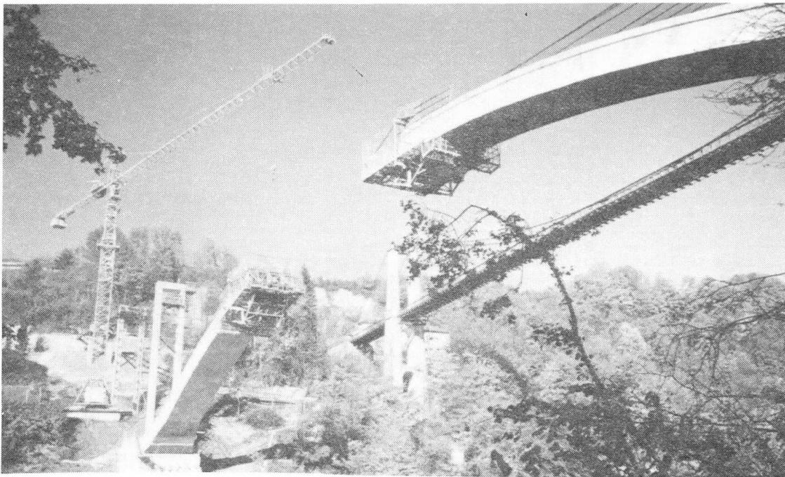
Après construction des pilettes sur l'arc, on procède à la mise en place du tablier. Il s'agit d'une dalle à deux nervures en béton précontraint dont les portées sont d'environ 20 mètres. Le tablier est réalisé sur une aire de préfabrication de 60 m de longueur, en rive gauche, puis poussé en place suivant une technique traditionnelle. La dissymétrie du chargement longitudinal de l'arc engendrée par le poussage est compensée par la remise en tension de certains haubans provisoires.
