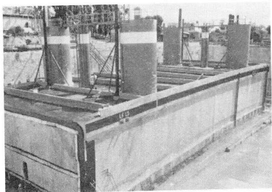
Les 2 voies de la traversée sous fluviale sont constituées de 7 caissons en béton armé précontraint construits dans une darse à l'abri de parois moulées. La fermeture de la darse se compose d'un gabion en palpanches et d'un bateau-porte en béton armé.
