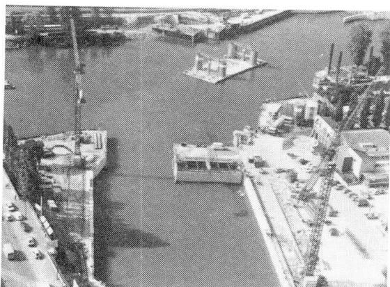
Les caissons sont mis en place par flottaison puis immersion, la manœuvre étant réalisée par treuillage, ballastage et cheminées d'équilibrage.
