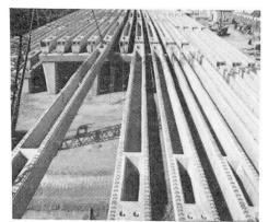
Les tabliers sont de largeur variable à poutres rayonnantes. A chaque extrémité de travée une entretoise en béton armé est réalisée pour rigidifier transversalement le tablier.
