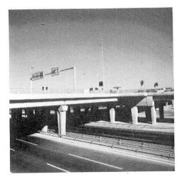
Les travaux ont consisté en la réalisation d'une section d'autoroute à 6 voies de 1 850 m de longueur, d'un viaduc de franchissement de 1 275 m et de 6 viaducs d'accès (1 115 ml).
