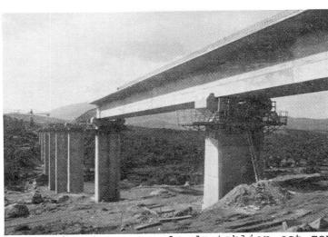
L'ouvrage comporte 10 travées ( 45 m + 8 x 50 m + 45 m) représentant une surface de tablier de 5341 m². Sa pente longitudinale est de 1.6 %.
