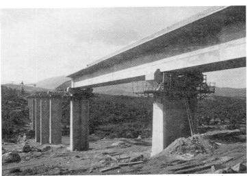
L'ouvrage comporte 10 travées ( 45 m + 8 x 50 m + 45 m) représentant une surface de tablier de 5341 m². Sa pente longitudinale est de 1.6 %.
