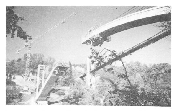
Après construction des pilettes sur l'arc, on procède à la mise en place du tablier. Il s'agit d'une dalle à deux nervures en béton précontraint dont les portées sont d'environ 20 mètres. Le tablier est réalisé sur une aire de préfabrication de 60 m de longueur, en rive gauche, puis poussé en place suivant une technique traditionnelle. La dissymétrie du chargement longitudinal de l'arc engendrée par le poussage est compensée par la remise en tension de certains haubans provisoires.
