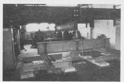
Mit einer eingebauten Kraftmeßdose konnte die jeweils wirkende Kraft in den einzelnen Laststufen genau bestimmt werden. Die Durchbiegungen wurden an 12 Punkten während der Probebelastung des Deckenfeldes und an 7 Punkten bei der Belastung des Nebenunterzuges gemessen. Weiterhin wurden folgende Meßdaten erfaßt:
