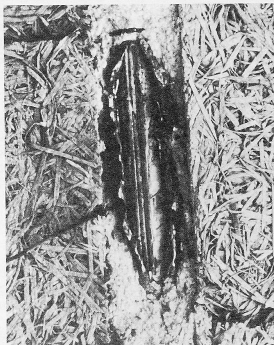
Fig.7 Vue d'un câble bien injecté après dépose du 1er panneau de fibres
