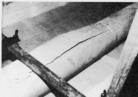
Fig.6 Eclatement du mortier à la coupe des tirants
