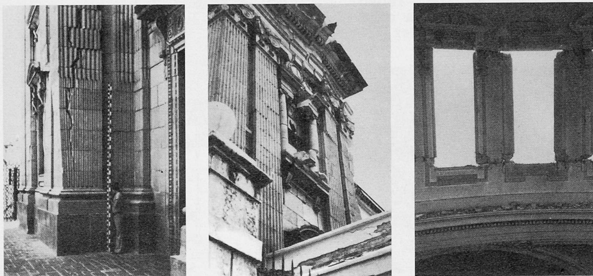
Fig. 7-8-9 Dégâts 1976. Respectivement tour Nord, tour Sud, supports du dôme.
