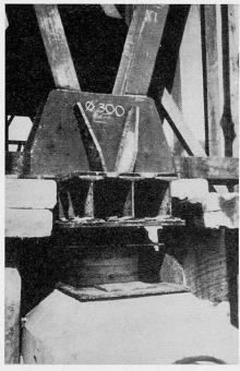
Fig. 14 Levage du dôme par vérins plats.
