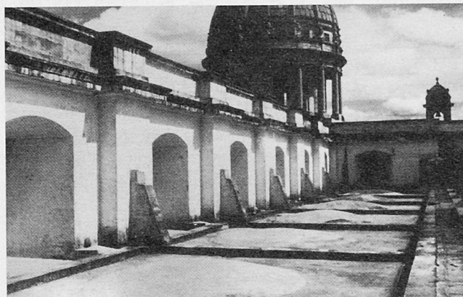
Fig. 4-5 Renforts exist. en béton armé. Charges verticales d'une travée.
