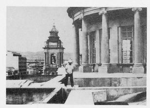
Fig. 16 Tirants sur toit 1979. Contournement du dôme.
