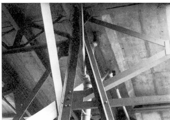
Fig. 2 Verstärkung der Querscheiben mit K-artiger Unterteilung
