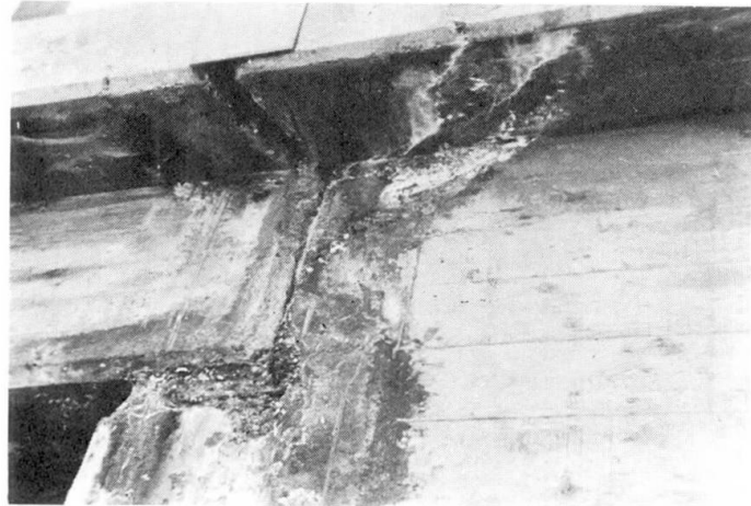
Fig. 2 Exemple de dégât de gel
