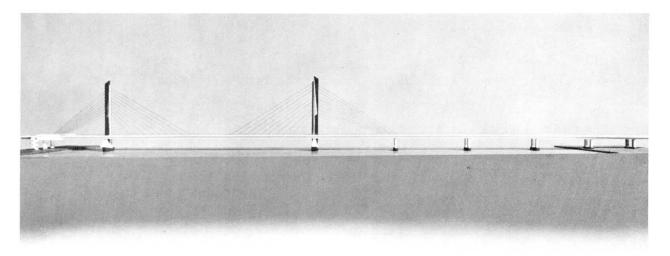
Fig. 15 Schrägseilbrücke - Vielseilsystem mit gleichbleibendem Balken
