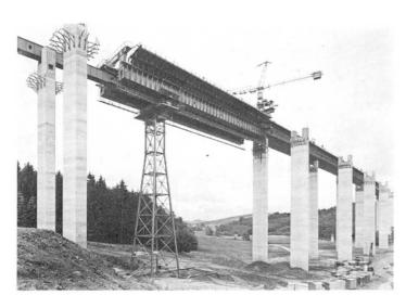
Fig. 12 Döllbachtalbrücke -Vorschubrüstung mit Zwischenstütze
