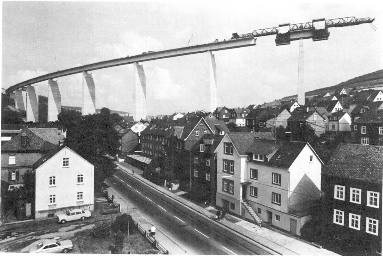
Fig. 11 Siegtalbrücke Eiserfeld - Bauzustand mit Vorschubrüstung
