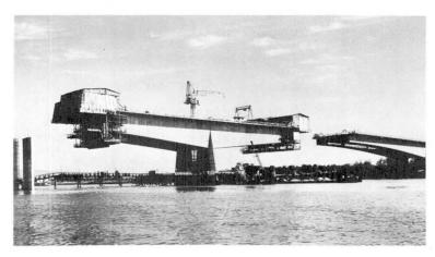
Fig. 9 Rheinbrücke Bendorf -Freivorbau in Spannbeton
