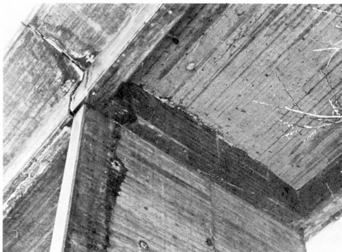
Fig. 12 Vue de l'articulation depuis dessous avant sa remise en état
