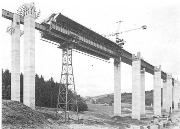
Fig. 12 Döllbachtalbrücke - Vorschubrüstung mit Zwischenstütze
