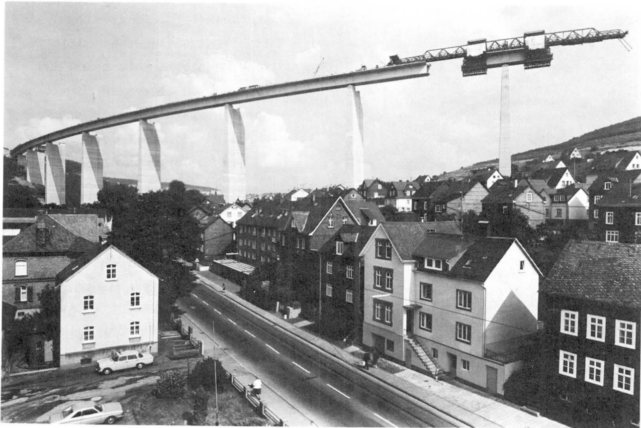
Fig. 11 Siegtalbrücke Eiserfeld - Bauzustand mit Vorschubrüstung
