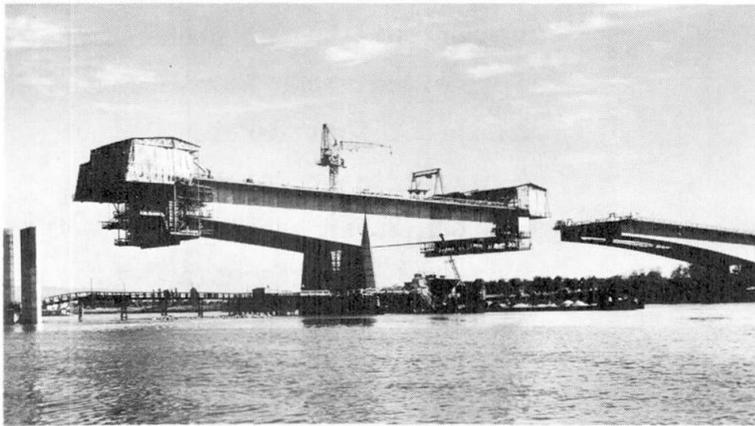
Fig. 9 Rheinbrücke Bendorf - Freivorbau in Spannbeton
