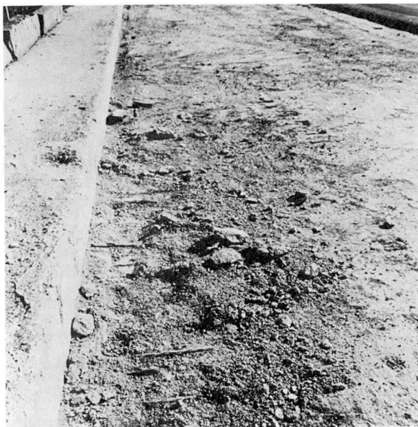
Fig. 4 Dégât de gel sous le revêtement
