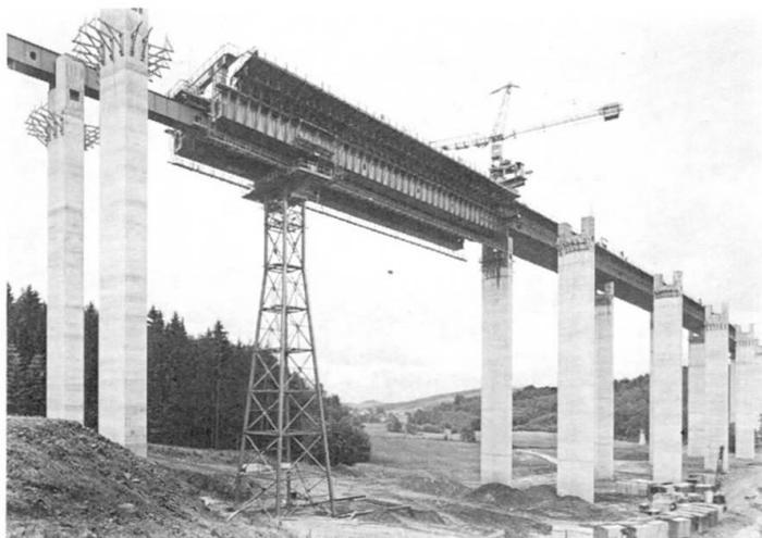
Fig. 12 Döllbachtalbrücke - Vorschubrüstung mit Zwischenstütze
