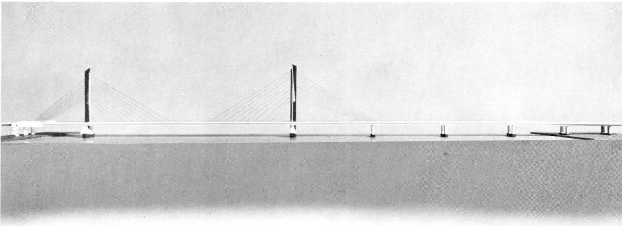
Fig. 15 Schrägseilbrücke - Vielseilsystem mit gleichbleibendem Balken
