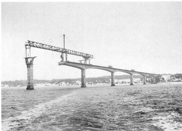
Fig. 14 Sallingsundbrücke - Montage
