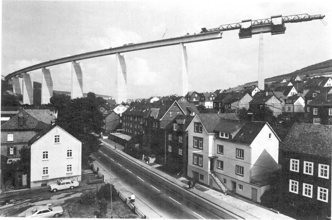
Fig. 11 Siegtalbrücke Eiserfeld - Bauzustand mit Vorschubrüstung
