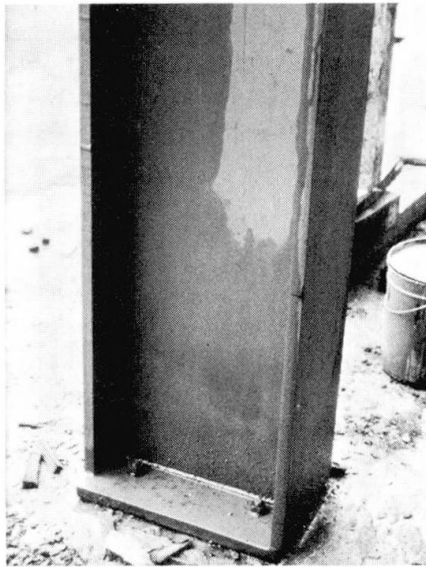
Bild 11a Angeschweisste Fussplatte
