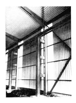
Bild 5 Halle mit von Binder zu Binder tragender Dacheindeckung
