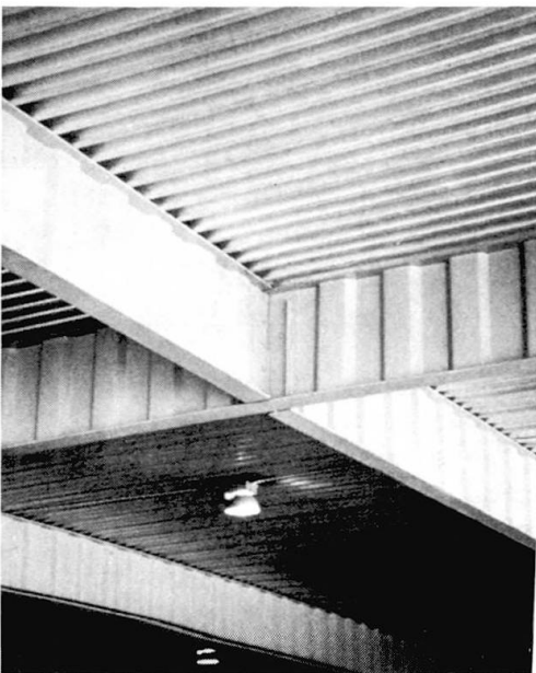
Bild 13 Träger mit gewelltem Steg
