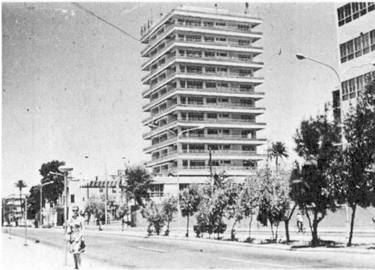
Bild 4: Stahlbetonskelettgebäude in Bagdad
