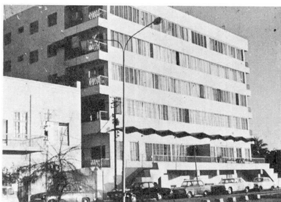
Bild 8: Wohnhaus in Bagdad
