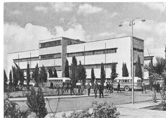
Bild 7: Universitätsgebäude in Mosul
