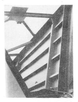
Bild 5: Detail des HV-Stoßes
