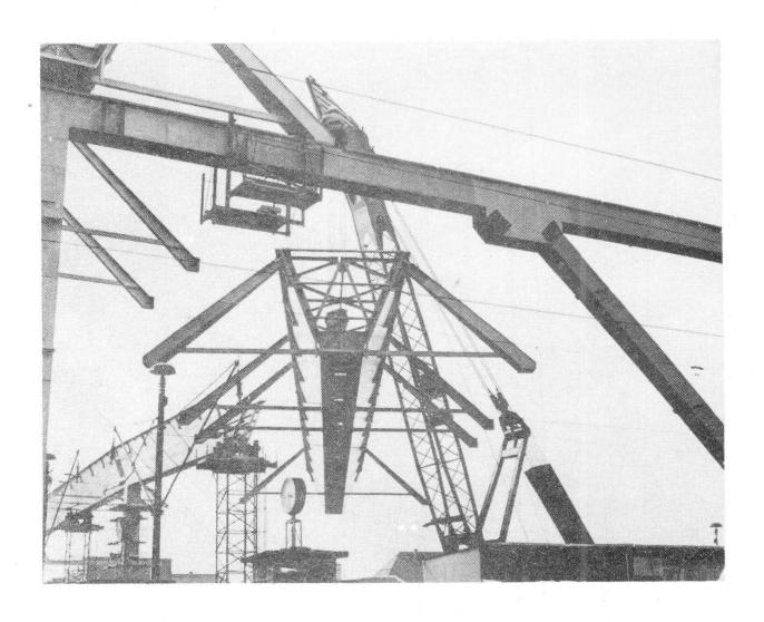
Bild 4: Montage mit Eisenbahndrehkran EDK 1000
