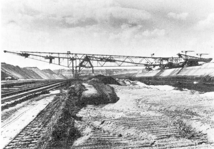
Bild 2: 60 m Abraumförderbrücke
