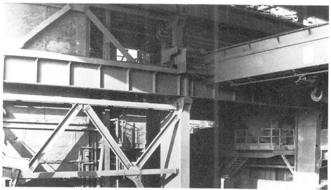
Bild 6: Lotrechter Verband in einem SM-Stahlwerk
