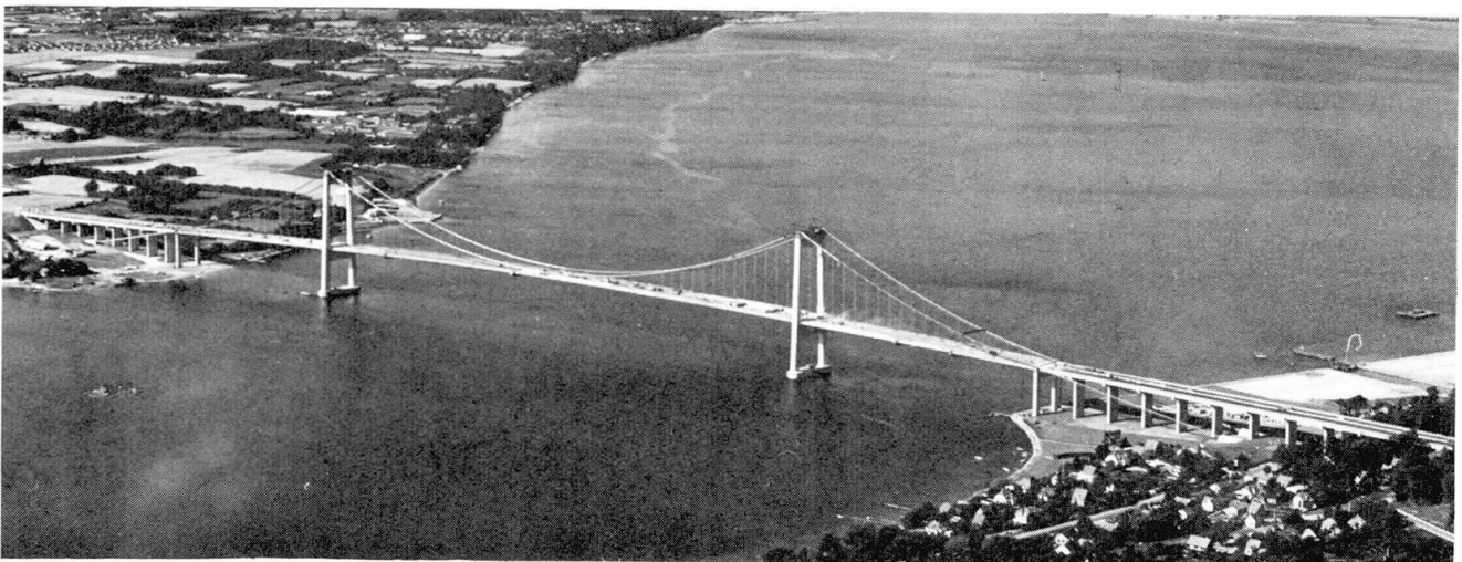
Fig. 1. Ansicht der fertigen Brücke.
