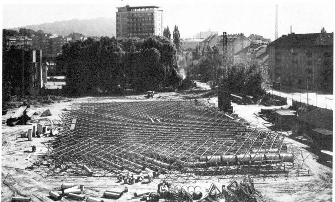
Abb. 6 - Montage der Zweilagen-Fachwerkdachplatten des Pavillons aus dem Baukasten "S".
