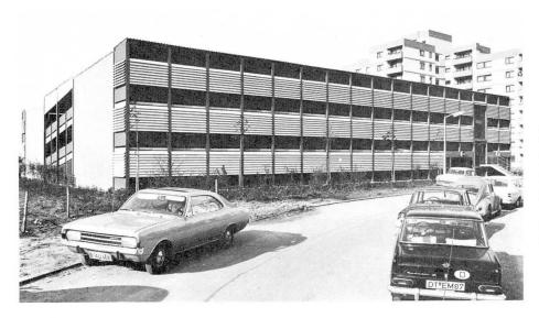
Bild 2: Außenansicht eines Parkhauses in Berlin-Rudow. Verkleidung der Fassade mit Asbestzementtafeln.
