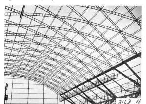
Teile, besonders der Auflagerungen an den Längseiten der Halle. Aus dem Bild 13 des charakteristischen Querschnittes der ersten Halle in Poprad geht hervor, dass hier Gewölbekonstruktion an beiden Längsseiten der Hallen auf schlanke, geknickte, konsolartige Stützen aufgelagert ist. Somit wird die Gesamtspannweite von 45m bis auf 70m vergrössert. Solche Lösung ermöglicht es auch das Gewölbe ohne Zugbänder auszuführen, siehe Bild 15.
