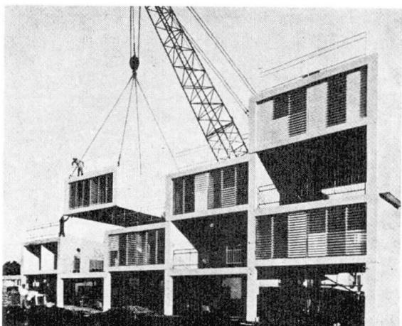
Fig.5 – Montage de cellules avec le système Shelley.
